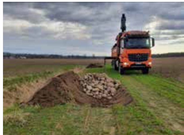
Abbildung 25: Verfüllen der Mulde mit Steinen
