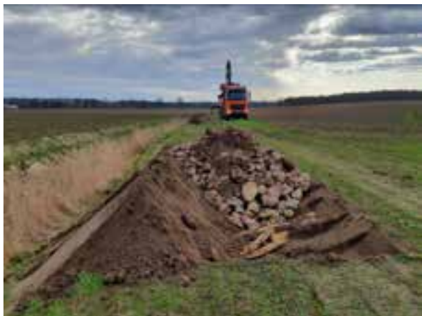
Abbildung 24: Bau der Ersatzhabitate, 50 - 80 cm tief ausgekoffert, Aushub an Nordseite des Ersatzhabitates abgelegt (und später verfestigt)
