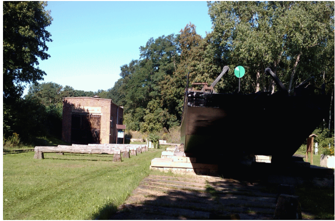
Abbildung 6: Eisenbahnfähre mit Lokschuppen &amp; Gleisen
