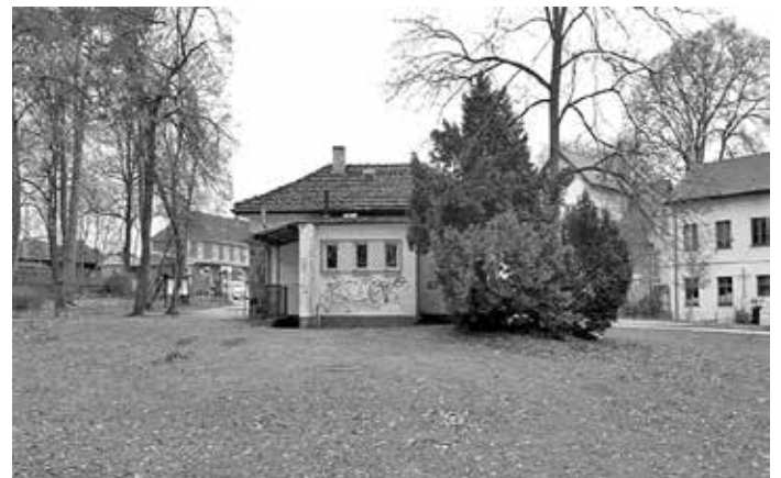
Südseite des Funktionsgebäudes
