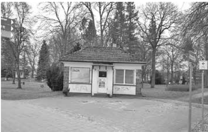
Nordseite des Funktionsgebäudes
