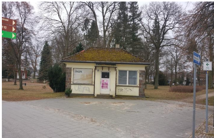
Nordseite des Funktionsgebäudes
